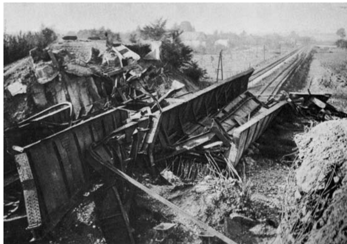
Het door de Duitsers opgeblazen viaduct over het mijnspoor bij Spaubeek kon de Amerikanen niet tegen houden.
